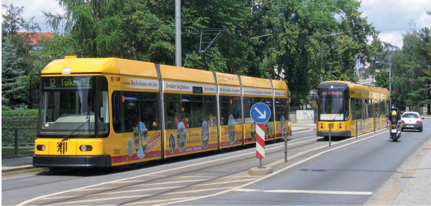
Dresdner Haltestellenlösungen wie dieses überfahrbare Haltestellenkap mit angehobener Fahrbahn finden deutschlandweit Anerkennung.
