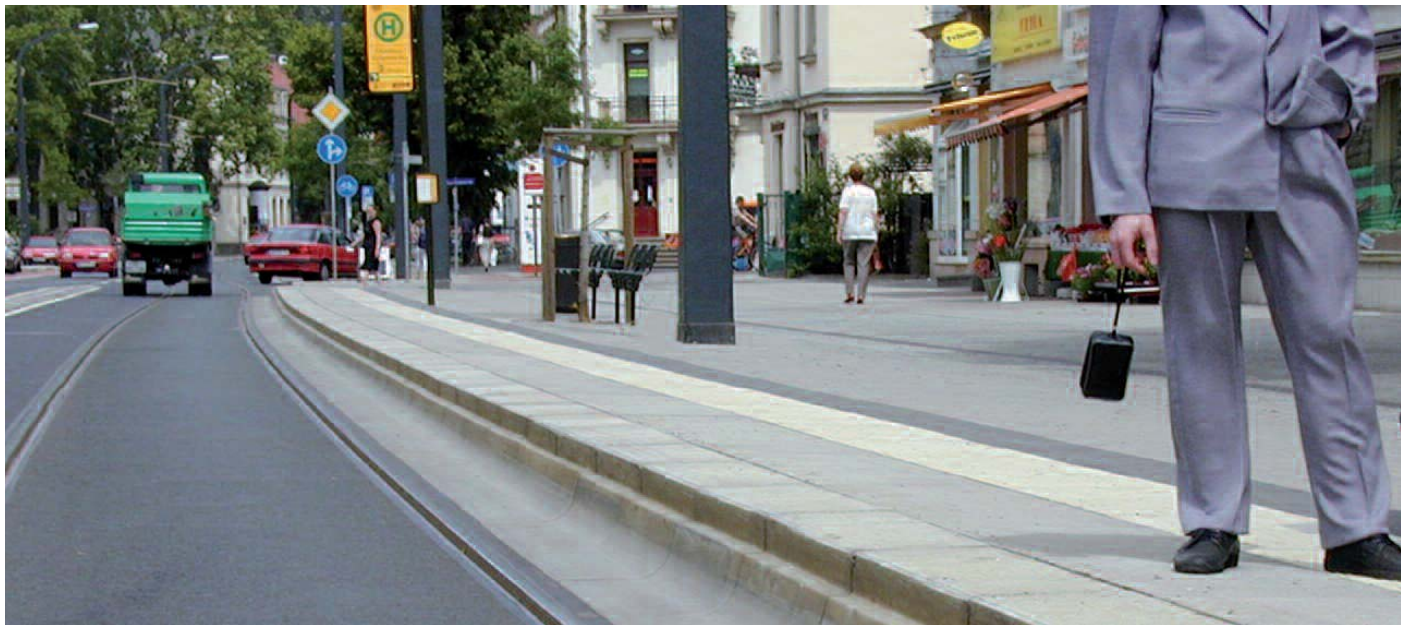
Der patentierte Dresdner Combibord ermöglicht es Straßenbahn und Bus gleichermaßen gut, an den Bahnsteig heranzufahren.
